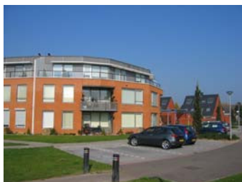
Woningen in Abersland en gestapelde nieuwbouw in De Geer
