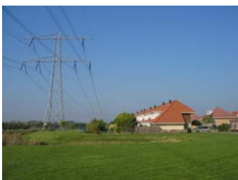
Zuidrand met hoogspanningsleiding
