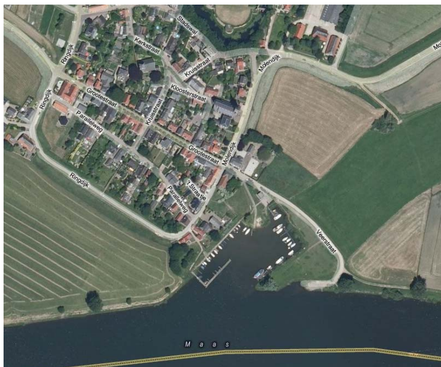
Overzicht bestaande situatie (voor realisatie van het hoogwaterveiligheidsproject Batenburg ter plaatse van de Maasarm)
