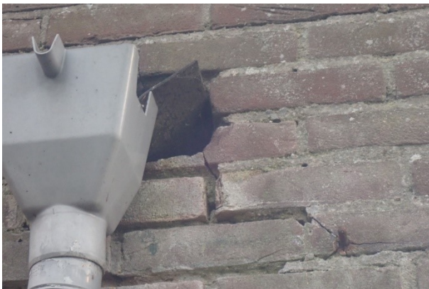
Foto 11: links, een opening nabij de regenpijp met toegang tot de spouwmuur.
