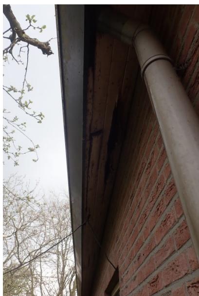
Foto 3: links, openingen onder het dak overstek.
