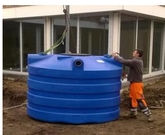
Voorbeeld aan te leggen ondergrondse tank en overloop voorziening (DuBoRain Infiltratiekolk)
