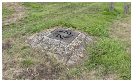
Voorbeeld aan te leggen ondergrondse tank en overloop voorziening (DuBoRain Infiltratiekolk)
