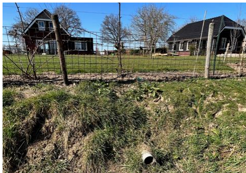
Verzamelleiding regenwater met uitmonding op opvangbassin Houtsestraat 14D
