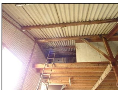
Figuur 7. Toegang zolder ruimte te slopen stal en aanzicht dak zonder beschot.
