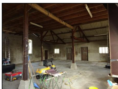
Figuur 6. Binnenzijde te slopen stal.
