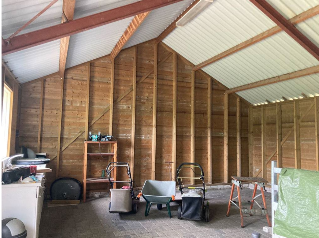
• Afbeelding 10: binnenzijde schuur (blijft behouden)
