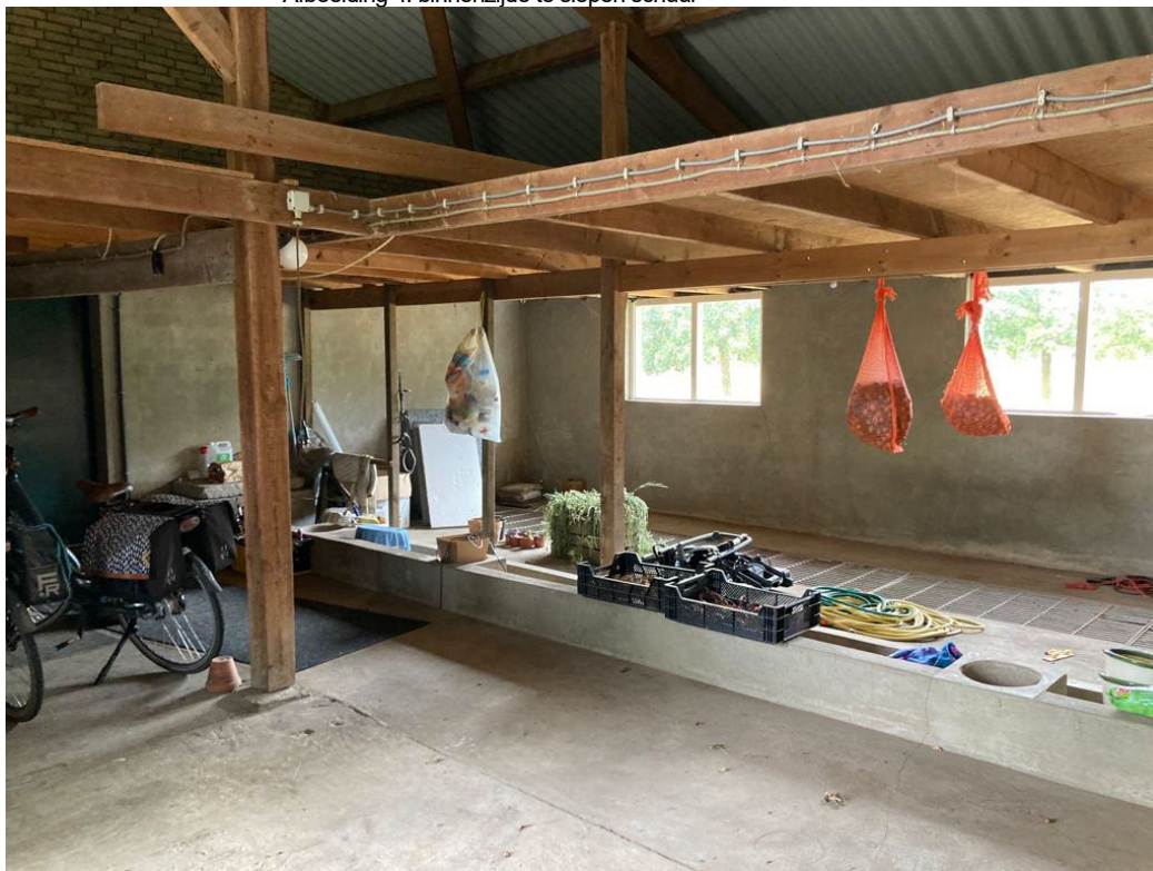
• Afbeelding 4: binnenzijde te slopen schuur
