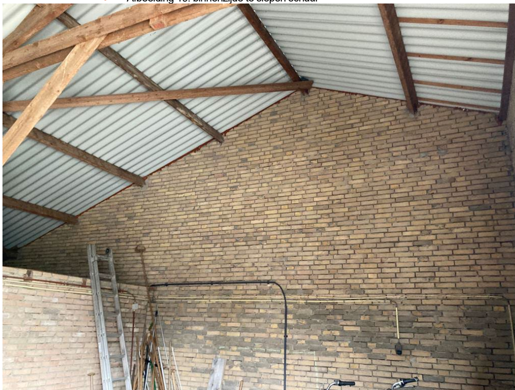
• Afbeelding 19: binnenzijde te slopen schuur
