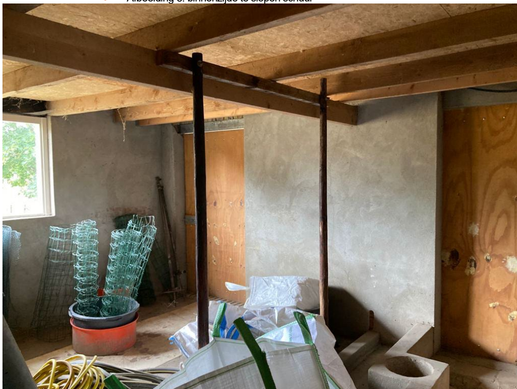
• Afbeelding 5: binnenzijde te slopen schuur
