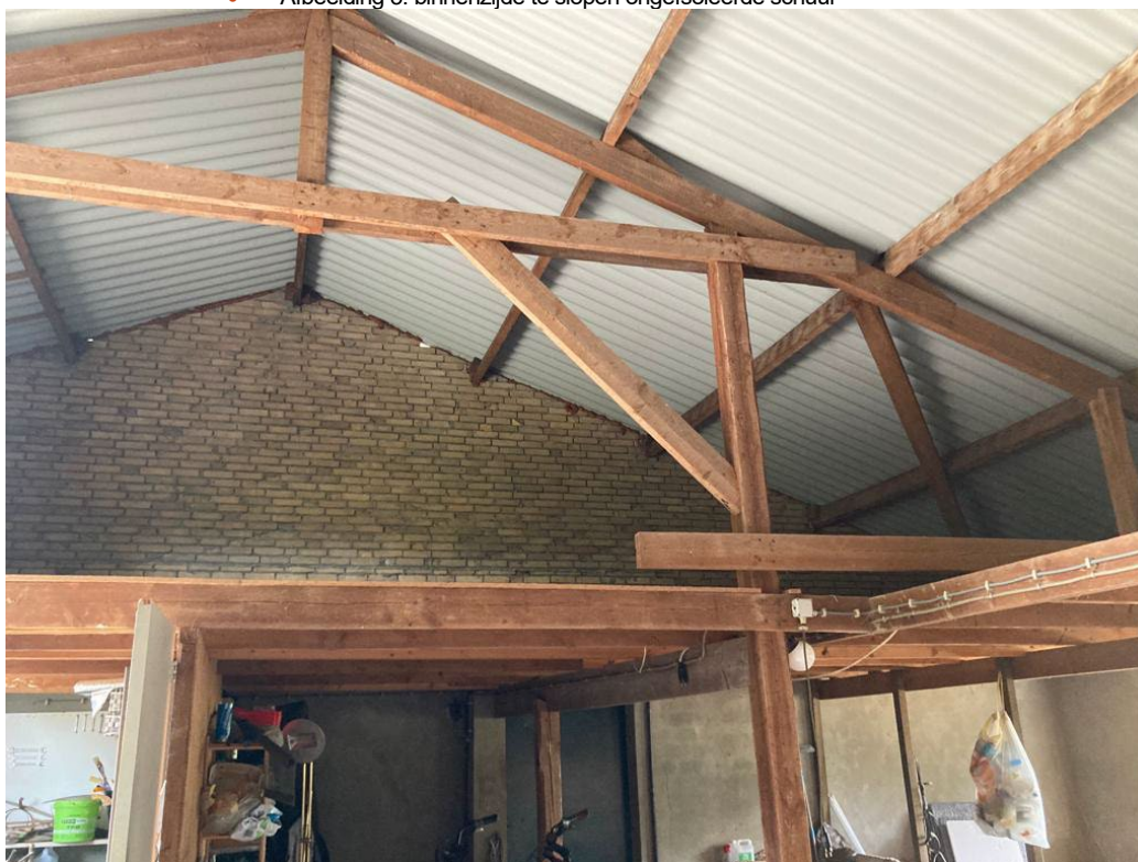
• Afbeelding 3: binnenzijde te slopen ongeïsoleerde schuur
