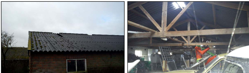
In de linker afbeelding zijn de verschillende invliegmogelijkheden zichtbaar van schuur 2 in het plangebied, in de rechterafbeelding is de schuur aan de binnenzijde te zien (in gebruik voor opslag).
