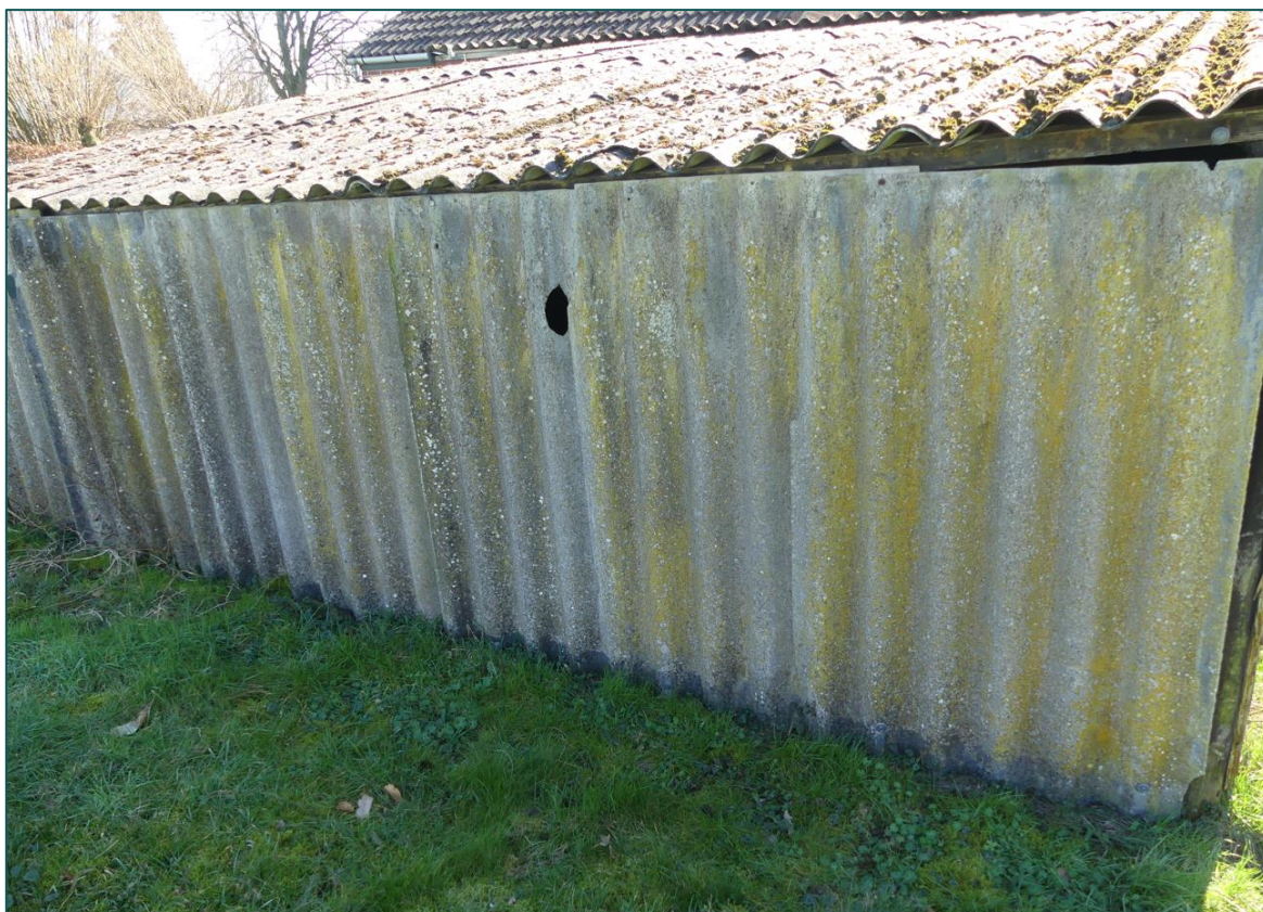
Figuur 3 De te slopen schuur 2
