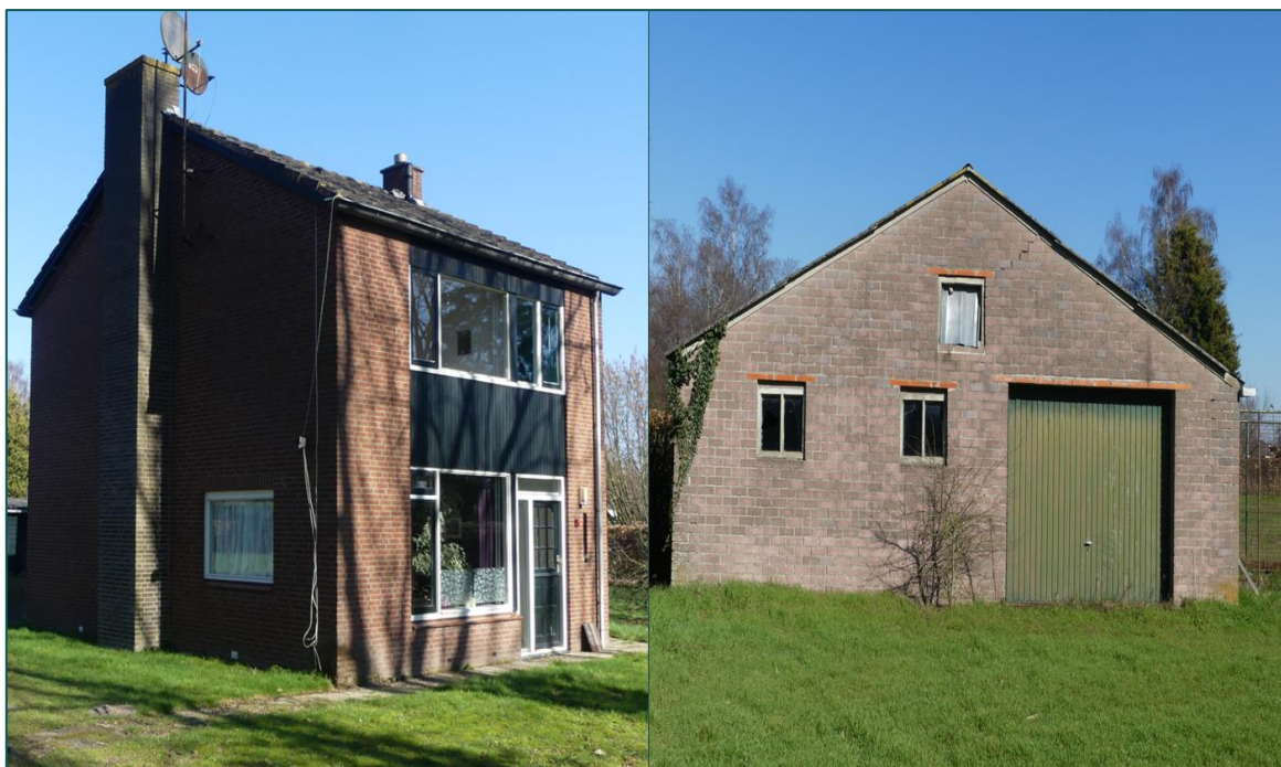
Figuur 2 Op de planlocatie blijven het woonhuis en schuur 3 onaangetast.
