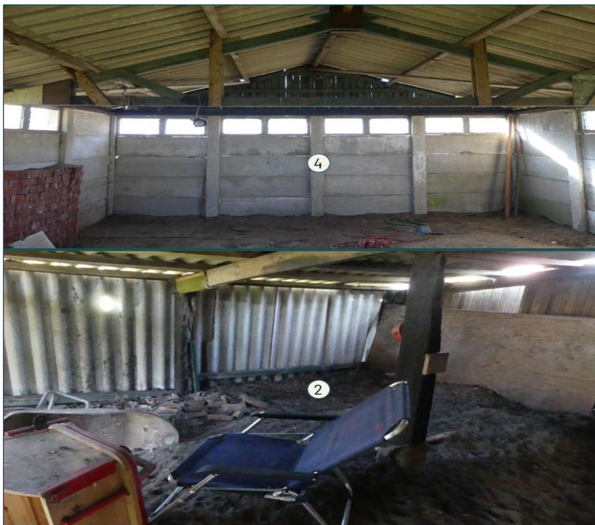
Figuur 3.3 De te slopen schuren 2 en 4. Er zijn veel kieren en openingen aanwezig. Het ontbreekt in beiden schuren aan wegkruip- en hangmogelijkheden en de kans op predatie is zeer groot.
