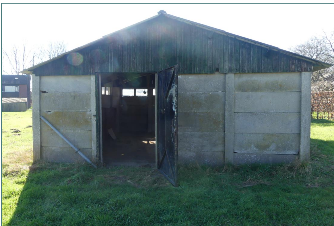
Figuur 4 De te slopen schuur 4.
