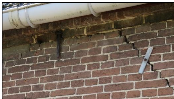
Foto 12. Scheuren en openingen in muur van woonhuis
