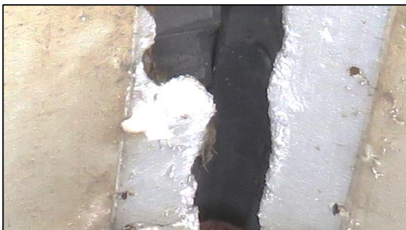
Foto 15. Gaten in piepschuim bij de nok van de oude varkensschuur met daarbovenop nestmateriaal
