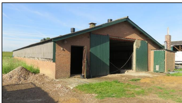
Foto 1. Noordzijde van de oude lege varkensschuur
