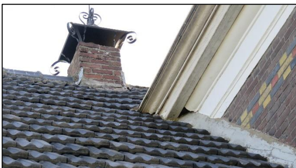
Foto 11. Opening in het dak van het woonhuis
