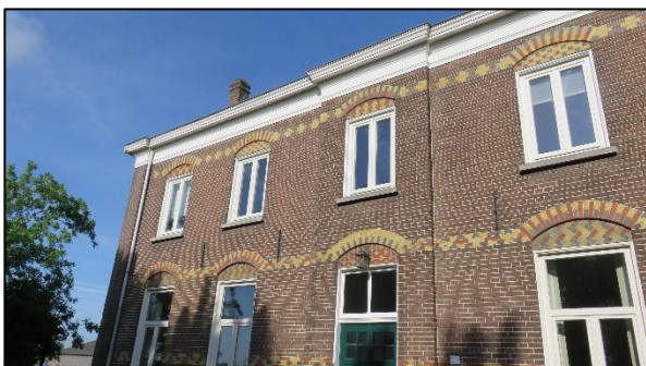
Foto 9. Oostzijde van het woonhuis
