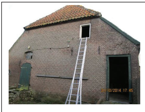
Foto 4: Zolder vloedschuur met toegangsluik.
