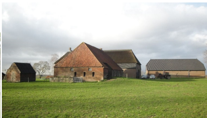
zicht op het achtererf, met de vloedschuur, de hoofdboerderij en aan de rechterzijde de voormalige graanschuur
