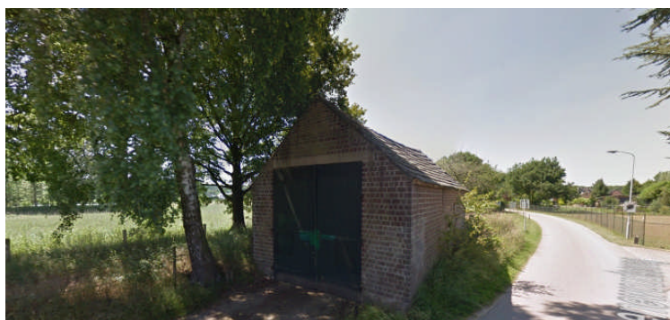
Figuur 11 Te slopen bebouwing zuidzijde Groenewoudseweg (bron: GoogleStreetview)
