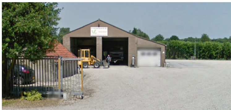
Figuur 10 Het rechter deel van het gebouw wordt gesloopt (witte roldeur) (bron: GoogleStreetview)
