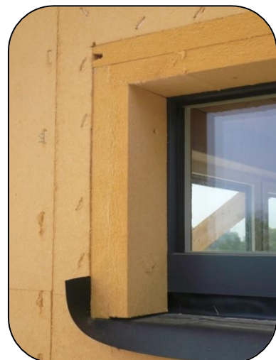
isolatie aan buitenzijde kozijn
