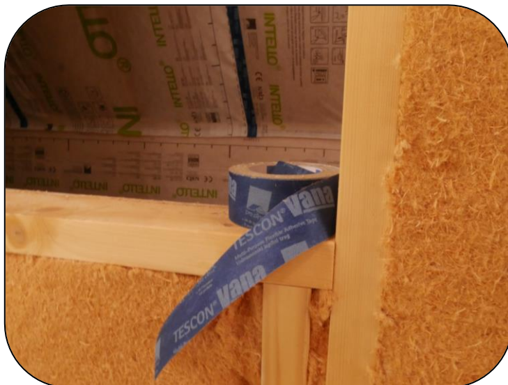
Tescon Vana kierdichtingstape iem Intello folie en houtvezelisolatie
