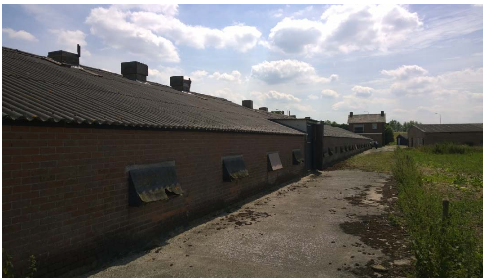
Foto 5. Opstal 4 perceel Niftrik
