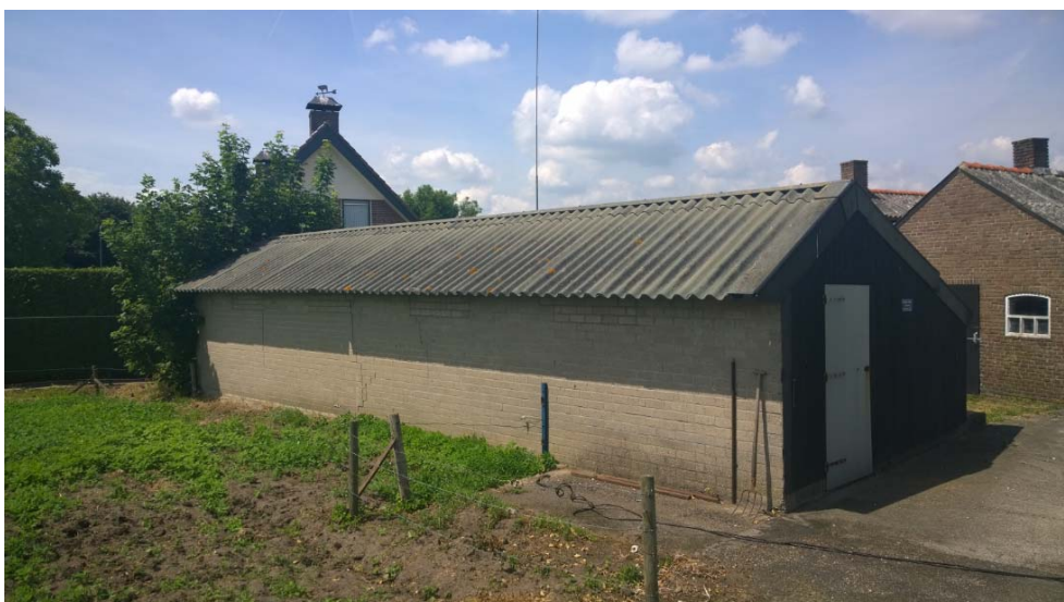
Foto 2. Opstal 1 perceel Niftrik
