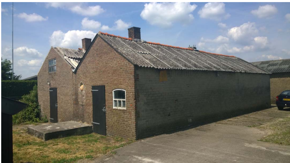
Foto 3. Opstal 2 perceel Niftrik
