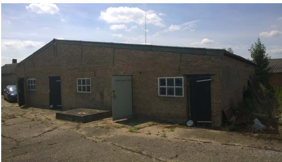
Foto 4. Opstal 3 perceel Niftrik
