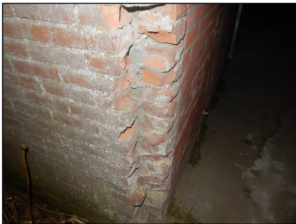
Figuur 15. Enkelsteens muur schuur/stal.
