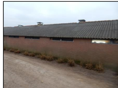
Figuur 5. Te slopen schuur westzijde.
