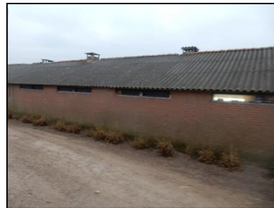
Figuur 5. Te slopen schuur westzijde.
