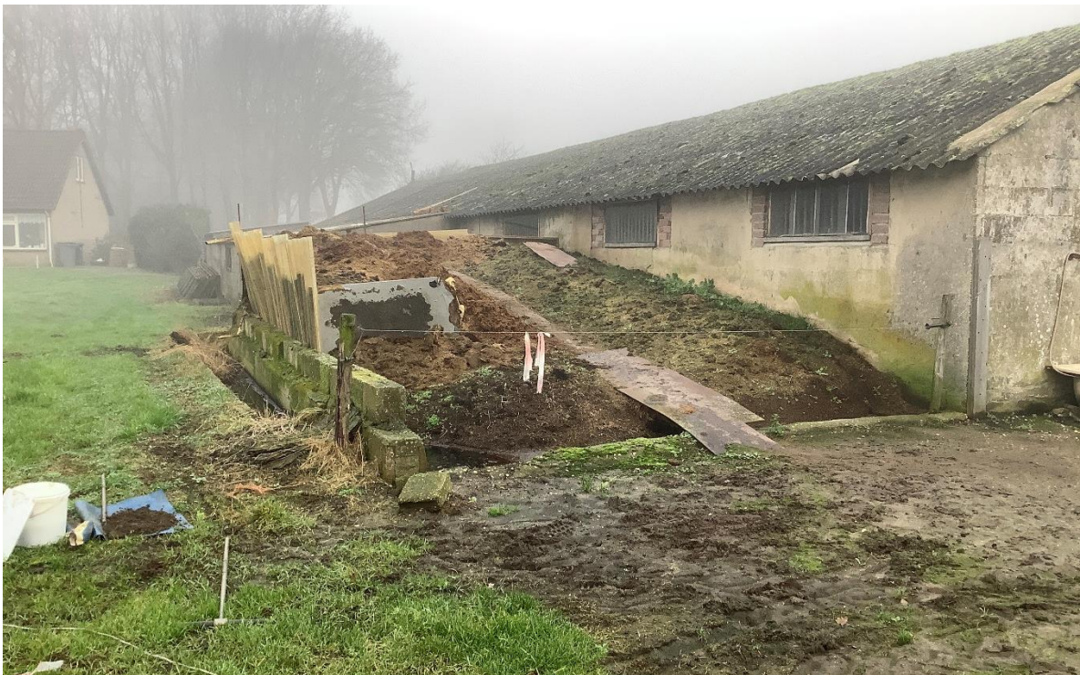
Foto van de onderzoekslocatie, nabij boring 111 – d.d. 16 december 2021
