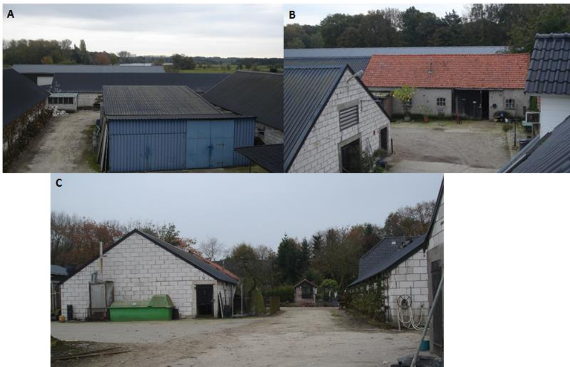
Afbeelding 2: foto's bedrijfsbebouwing plangebied
