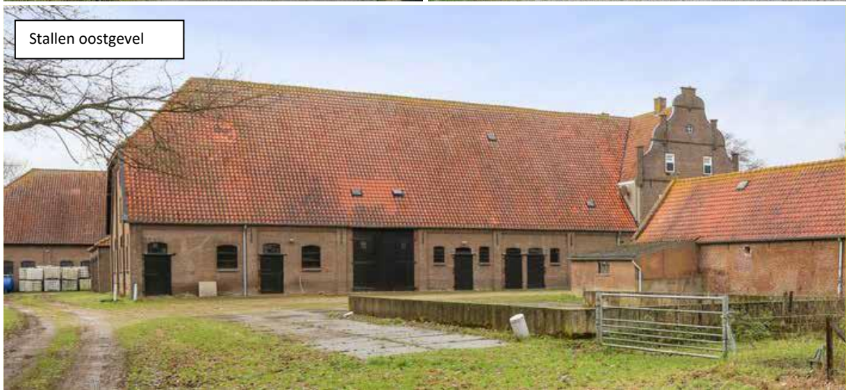
Afbeelding 2.2: Foto's bestaande situatie
