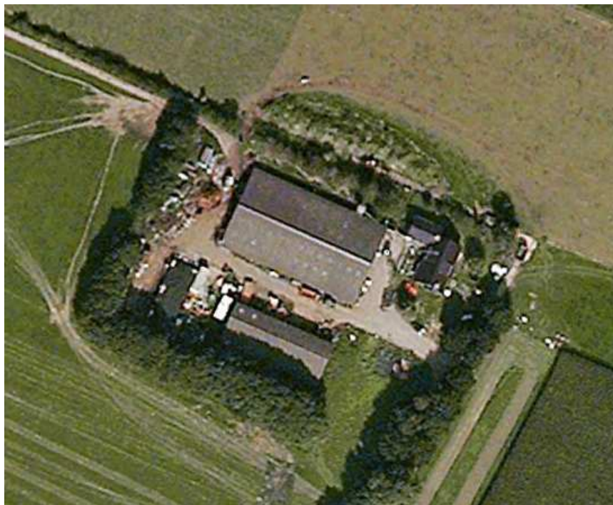
Figuur 2. Huidige situatie (zonder in 2011 verleende vergunning ligboxstal) Bron: DLV Bouw, Milieu en Techniek B.V.
