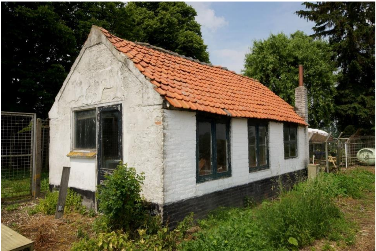
Bestaand bijgebouw met daarachter propaantank
