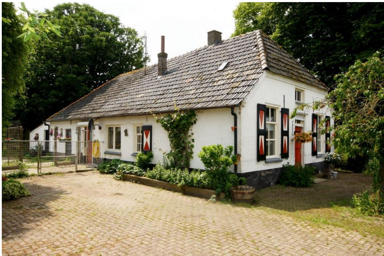
Aanzicht bestaande woning
