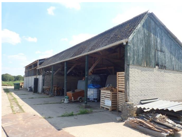
Foto 11: links, werktuigenloods en werkplaats.
