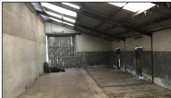
Foto 6. Schuur in het zuiden van het plangebied
