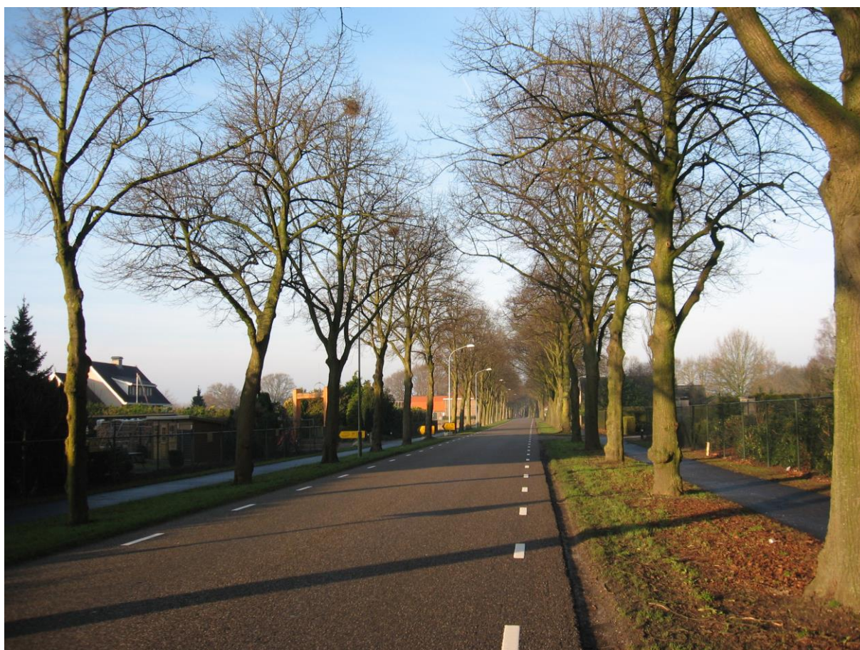
Figuur 1. Karakteristiek beeld van het traject van de Oosterweg buiten de bebouwde kom van Wijchen, ter hoogte van het plangebied (rechts) en ongeveer 300 m noordwestelijk van de rotonde. De weg heeft een laanbeplanting in een circa 3 m brede tussenberm. De 5½ m brede asfaltverharding is voorzien van kantstrepen en aan beide zijden ligt –achter de bomenrij– een verplicht fietspad van bijna 2 m breed. De snelheidslimiet is 60 km/uur [foto 5 januari 2015]
