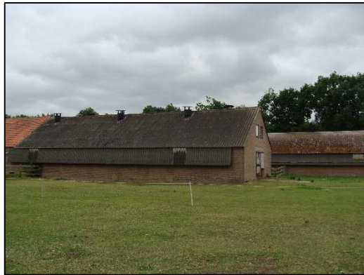
Foto 7. Weide en te slopen stallen
