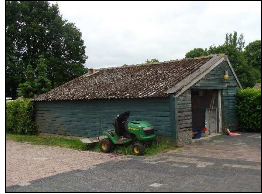
Foto 6. Te slopen opstal
