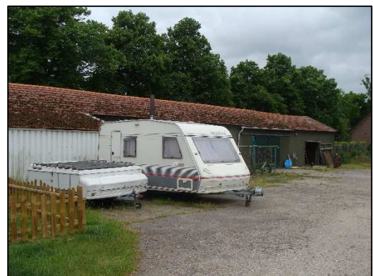
Foto 10. Te slopen gebouw in zuiden plangebied
