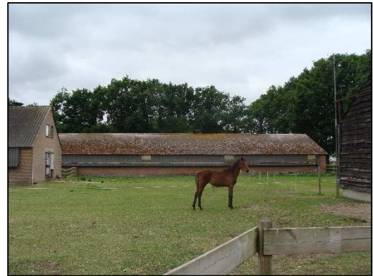
Foto 8. Weide en te slopen stallen
