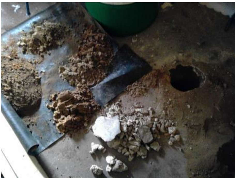
Foto 2: boring 29 in de voormalige kippenschuur
