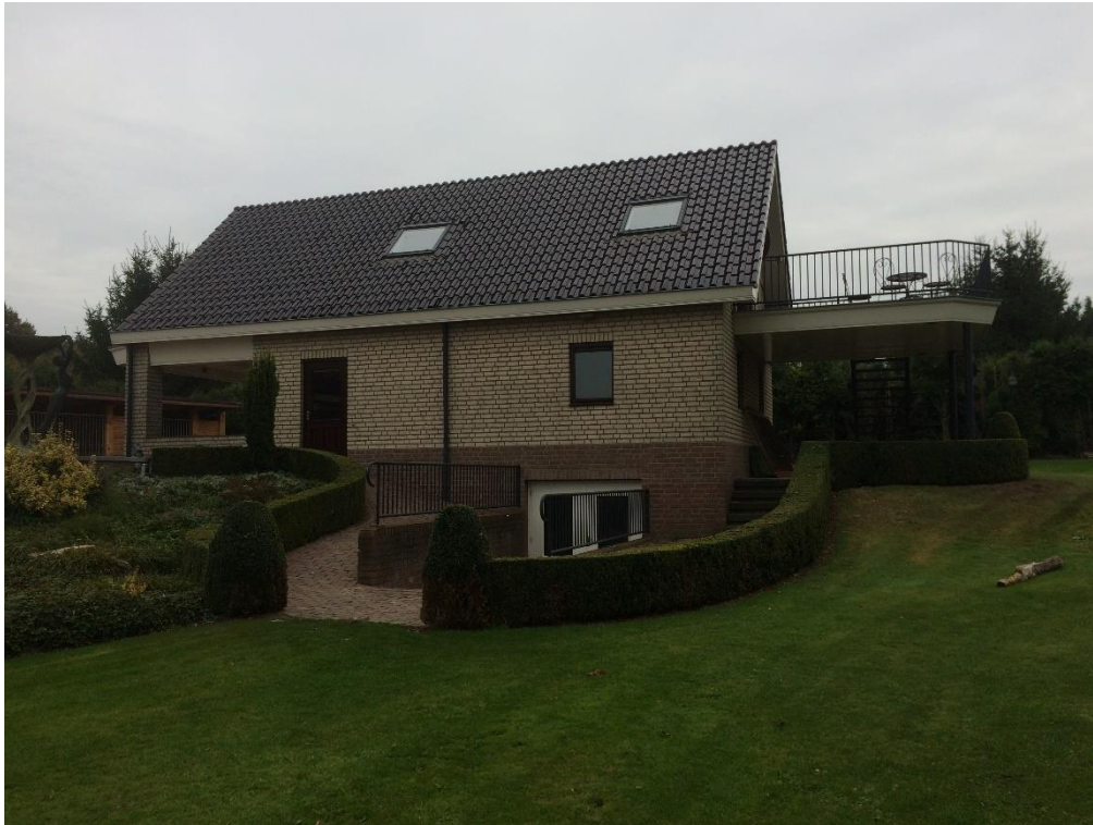
Bijgebouw aan de Oosterweg 290
