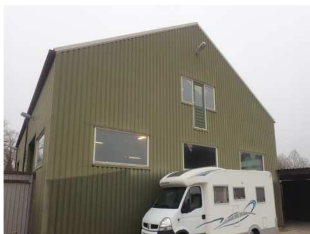
Foto 2: rechts, westzijde van het bedrijfsgebouw.
