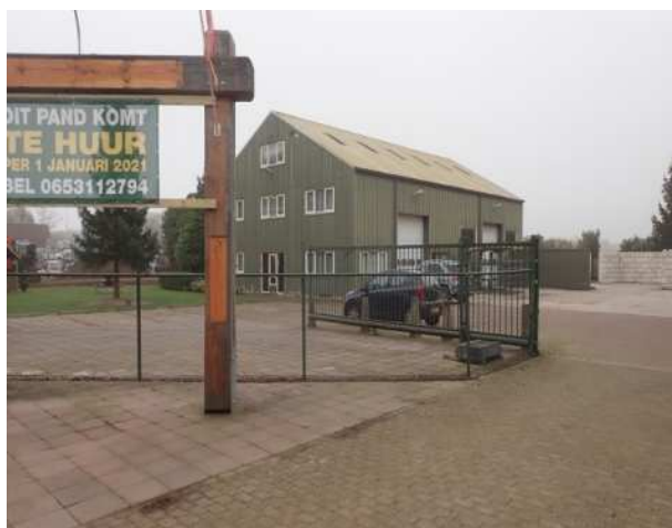
Foto 15: links, het verharde erf naast het bedrijfsgebouw.
