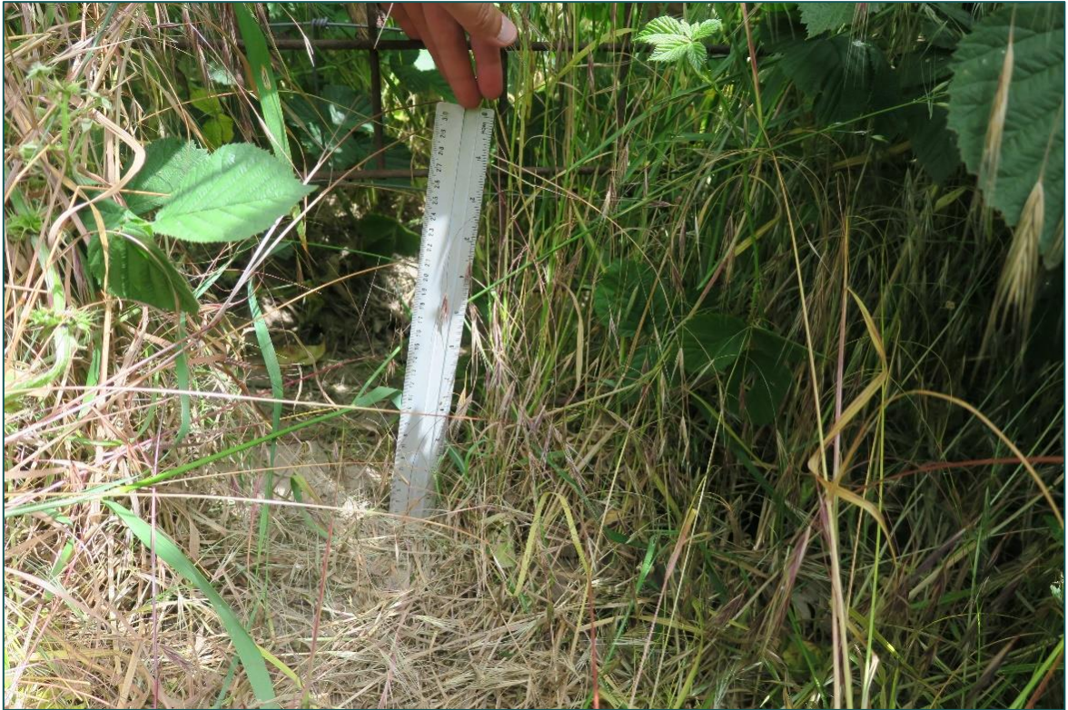
Figuur 7 Nummer 6: doorgang onder hekwerk.
