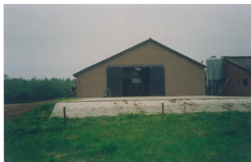
Foto van de bestaande stal en bijbehorende voorzieningen (verhardingen), die aan de achterzijde uitgebreid zal worden.
