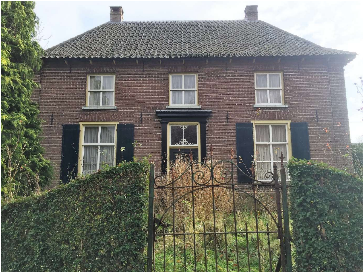
de voorgevel voor aanvang van de restauratie met de omlijste ingang, hoekpilasters, metselwerk en het tuinhekje
