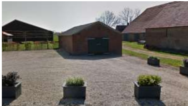
Figuur 14: Vml. locatie bovengrondse dieseltank
