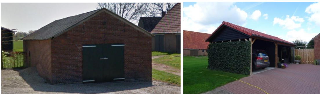
Afbeelding 5 en 6: de te verwijderen schuur en verplaatsen tuinkamer met carport. Bron: Google & Rik Bijvelds. Datum: 22-07-2020
