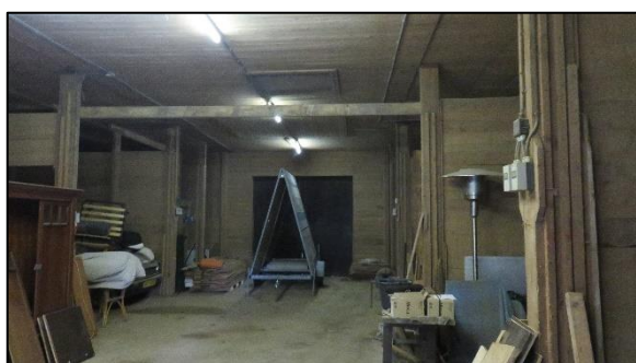
Foto 5. Binnenkant van de schuur
