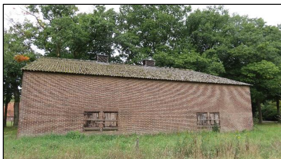
Foto 3. Achterzijde van de schuur
