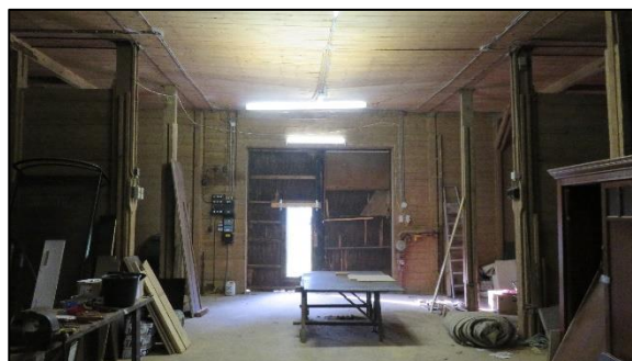
Foto 4. Binnenkant van de schuur
