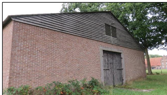
Foto 2. Zuidzijde van de schuur
