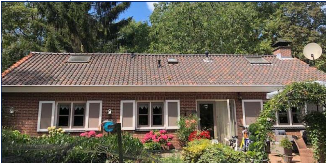
Woning Wezelsedijk 2 vanuit achtertuin
