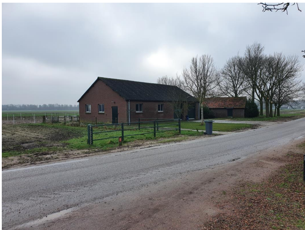
Figuur 1 De planlocatie bestaande uit een garage opgetrokken uit gemetselde muren met golfplaten dak en een kippenhok opgetrokken uit gemetselde muren met pannendak.
