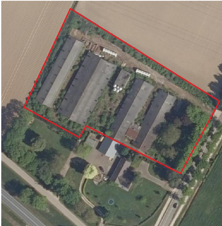
Afbeelding 4: Luchtfoto van het plangebied (bron: www.ruimtelijkeplannen.nl )
