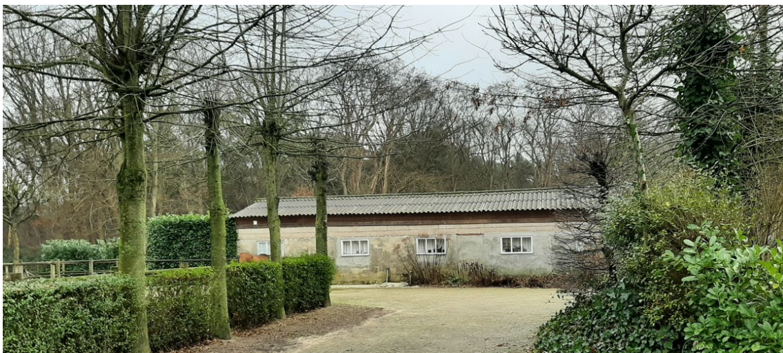
Afbeelding 6: Foto's huidige situatie westzijde van het bijgebouw
