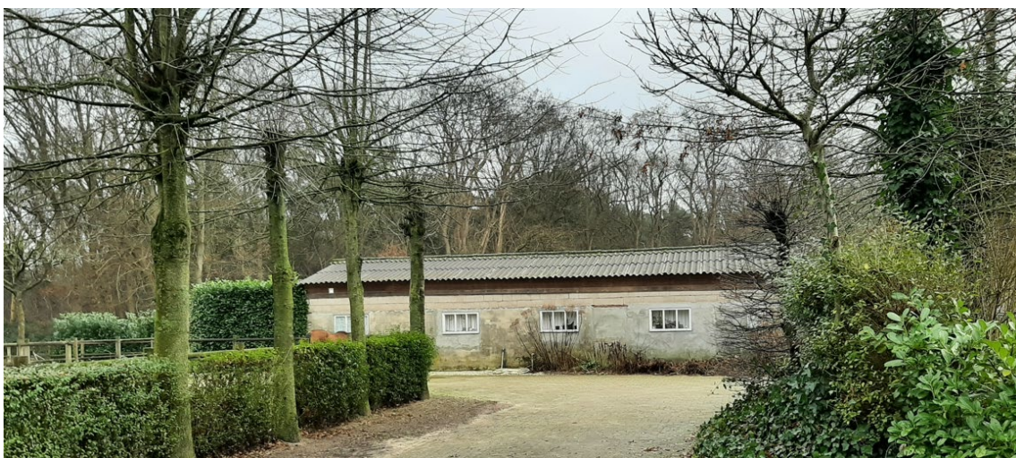
Afbeelding 6: Foto's huidige situatie westzijde van het bijgebouw
