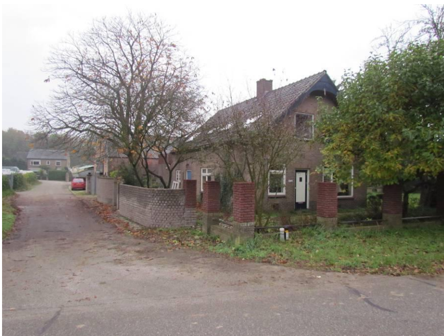
Voorzijde te behouden bestaande woning
