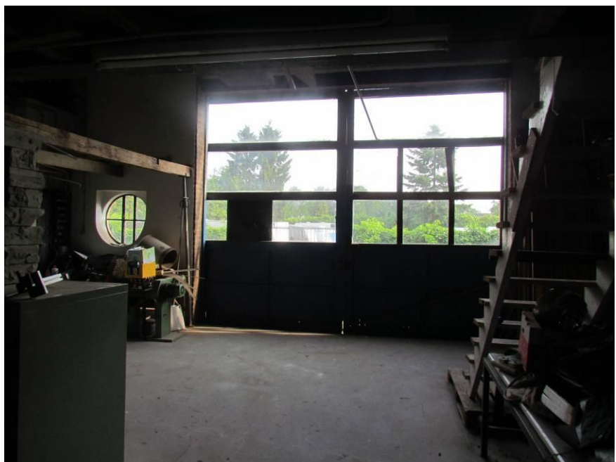
bestaande schuur te transformeren naar woning
