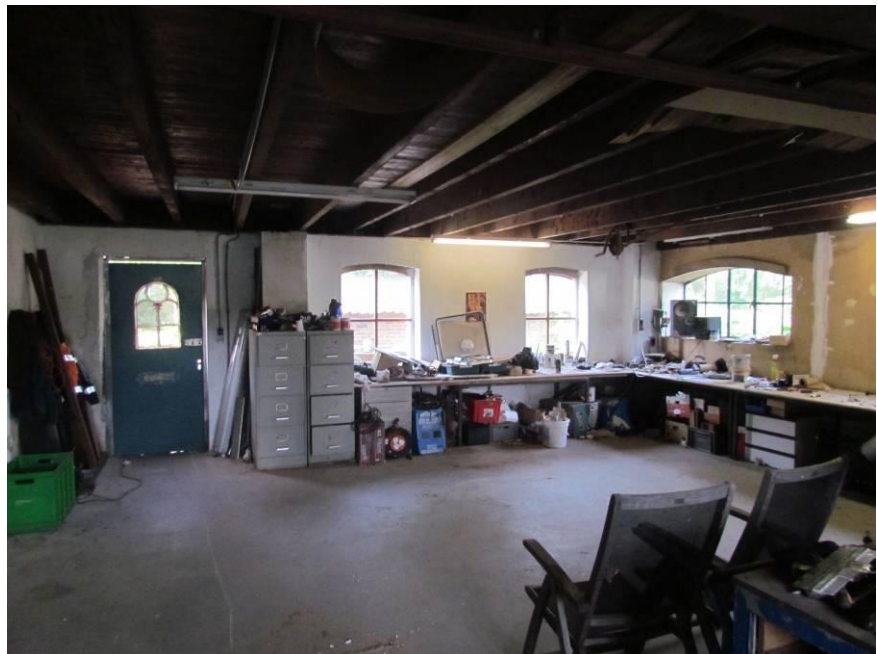
Naar woning te transformeren schuur
