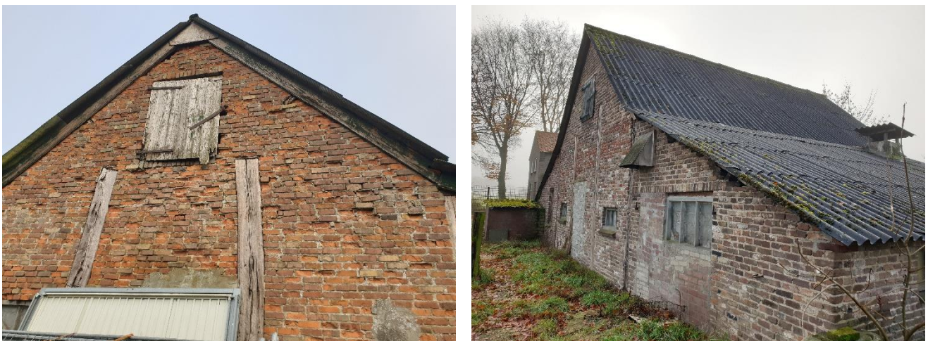
Afbeelding 4: tijdens het veldbezoek is geen kerkuil aangetroffen, wel zijn in meerdere gebouwen geschikte invliegopeningen aanwezig.
