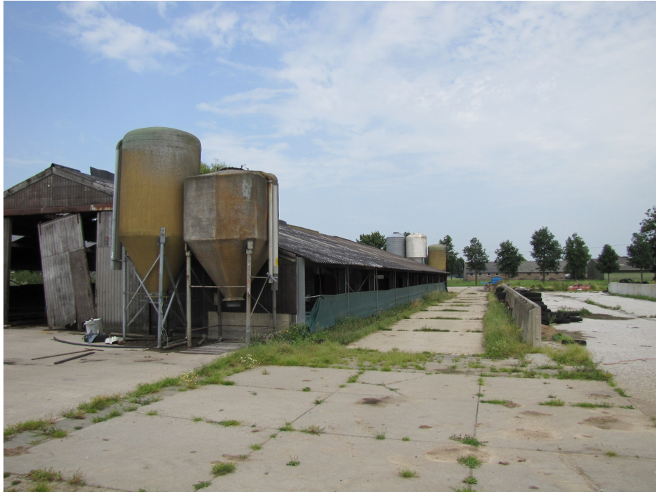
Afbeelding 3. De te slopen stal.
