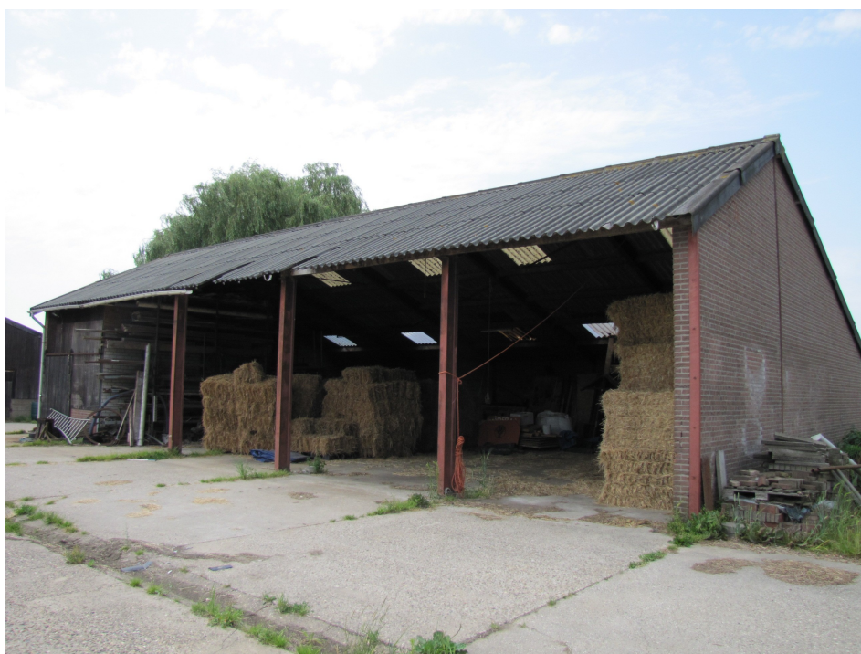
Afbeelding 2. De te slopen karrenloods.
