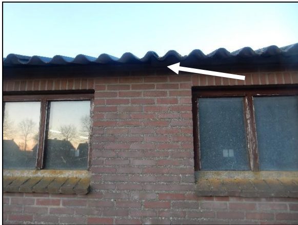
Figuur 13. Spouw via golfplaten dak toegankelijk.
