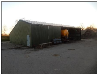
Figuur 3. Te slopen open kapschuur.
