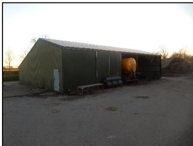
Figuur 3. Te slopen open kapschuur.
