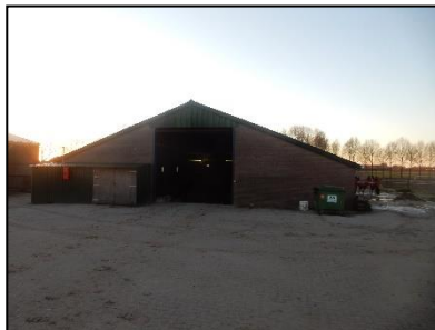
Figuur 4. Te slopen grote schuur op de locatie.
