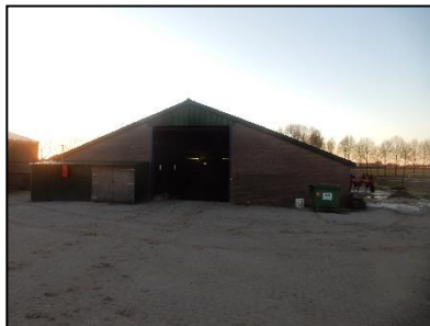
Figuur 4. Te slopen grote schuur op de locatie.
