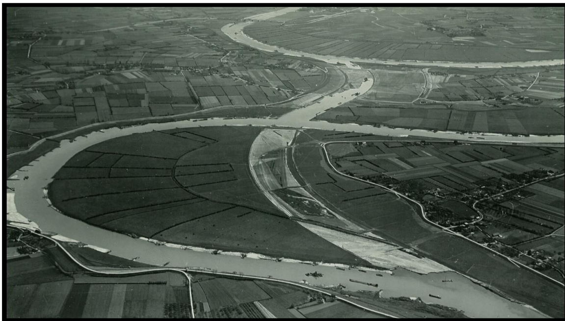
Afbeelding 15. Luchtfoto van de Maaskanalisisatie bij Balgoij (links) en Keent in 1938 (bron: Gelderarchief).
